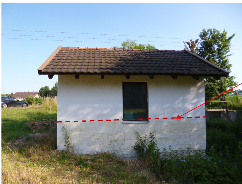
Sichtbare Hochwassermarke 2013 ca. 310,10 m ü.NN
