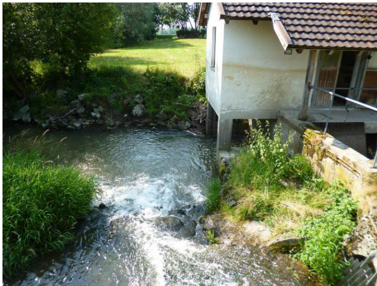
Turbinenhaus mit Unterwasserkanal
