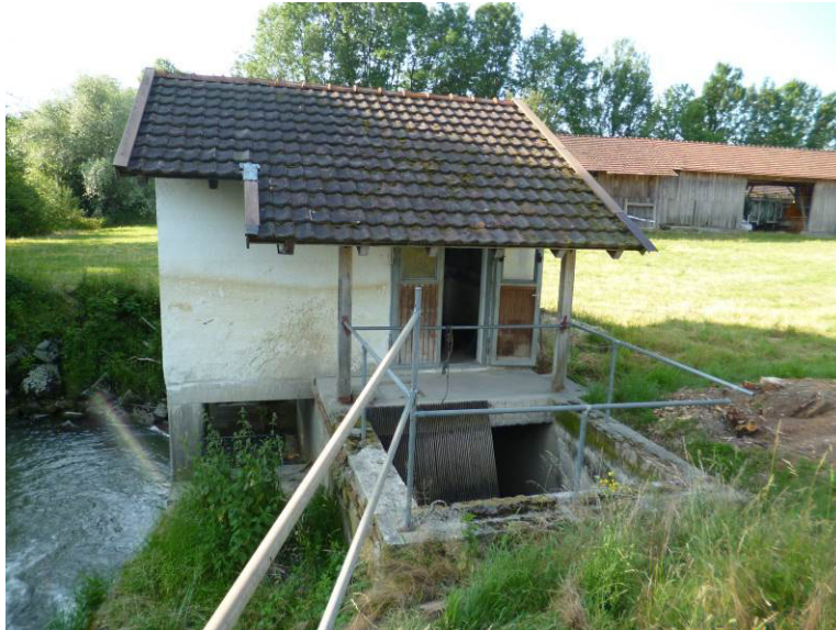
Wasserschloss mit Feinrechen (teilweise ausgebaut)
