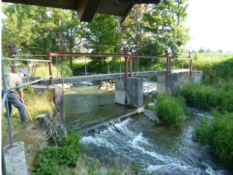
Wehranlage, Schützen und Windwerke derzeit zur Reparatur ausgebaut
