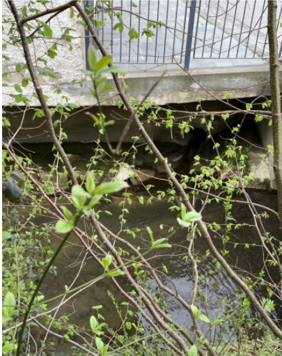
Ansicht Einleitung E8
