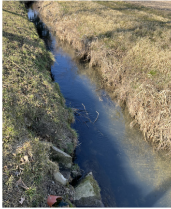
Ansicht Einleitung E4
