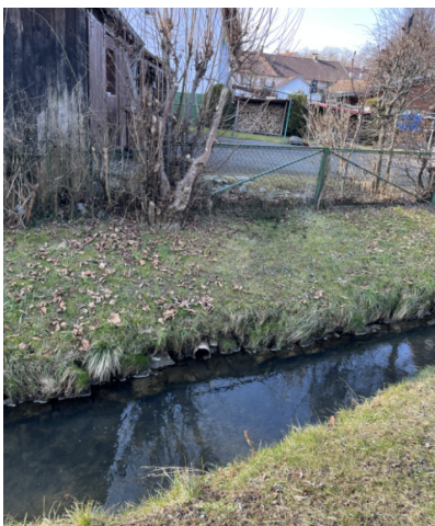
Ansicht Einleitung E9
