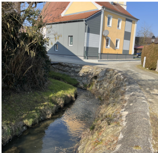
Ansicht Einleitung E18
