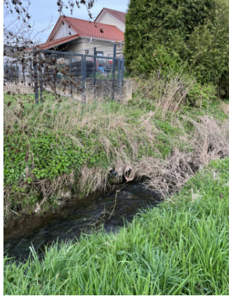
Ansicht Einleitung E06
