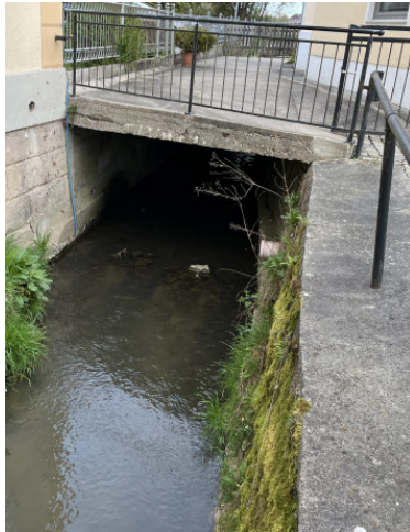
Ansicht Einleitung E17
