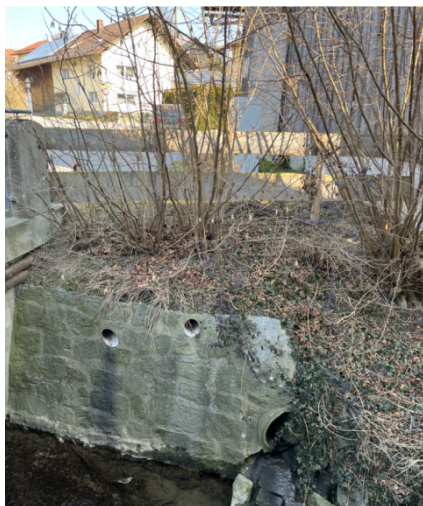
Ansicht Einleitung E7
