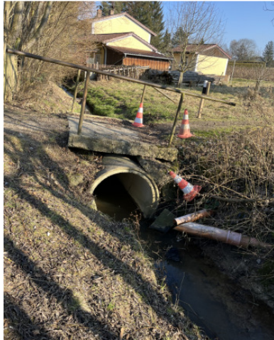
Ansicht Einleitung E20
