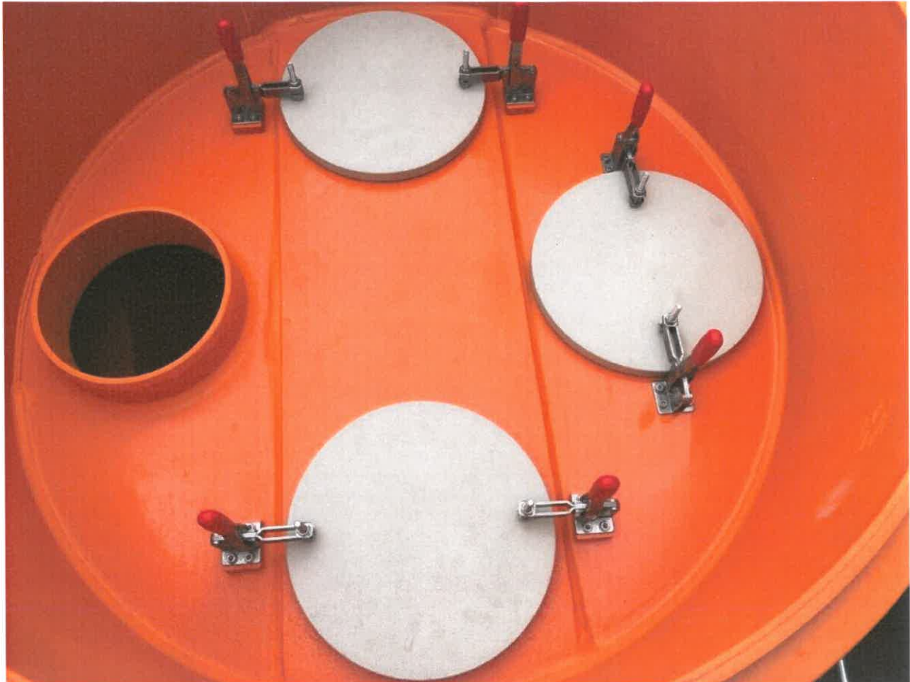
Bild 3: Blick in den Substratschacht mit Auslaufkammer – offen (links), Substratkammer mit zwei Öffnungen (Mitte) und Zulaufkammer (rechts).
