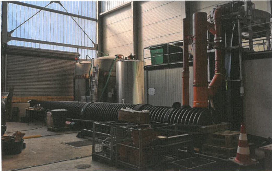
Bild 1: Prüfaufbau für die AFS- und MKW-Prüfung (Zulauf und Anfang der Anlage).
