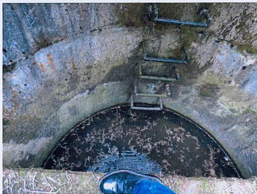
Einlaufbereich mit Dauerstau
