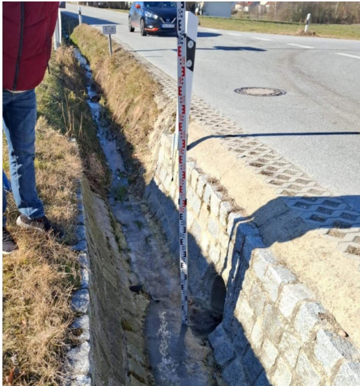
Straßengraben entlang der PA 75, Einleitungsstelle nach Regenrückhaltung
