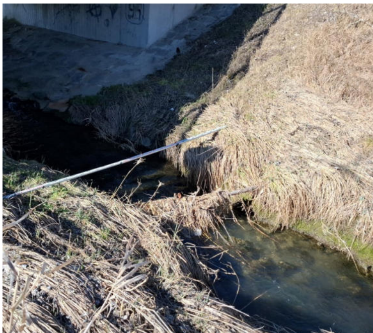
(Blick zur Wolfach, links die Einleitungsstelle des Grabens)
