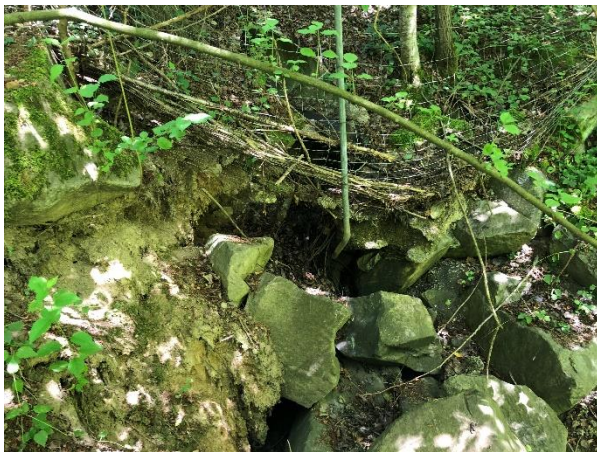
Abbildung 4.9: Auskolkungen unterhalb des Auslaufs
