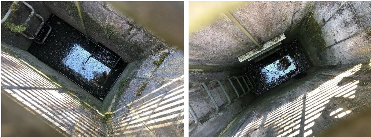
Abbildung 4.7: Drosselschacht, Zulaufbereich mit Schieber DN200 vor Grundablass und Tauchwand vor Drosselöffnung (li.) sowie Ablaufbereich mit Absperrschieber DN600 vor Ablaufleitung
