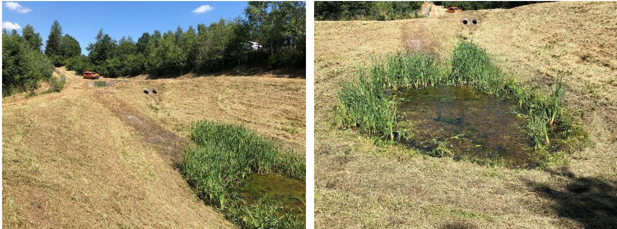
Abbildung 4.5: Regenrückhaltebecken, Blick Richtung Auslauf Absetzbecken (li.) und Blick auf Beckensohle (re.)
