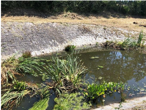
Abbildung 4.2: Absetzbecken, Blick auf befestigtes nordöstliches Ufer
