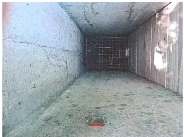
Foto 8: Mönchbauwerk, Gitterrost und Ablauf DN 150 nach unten
