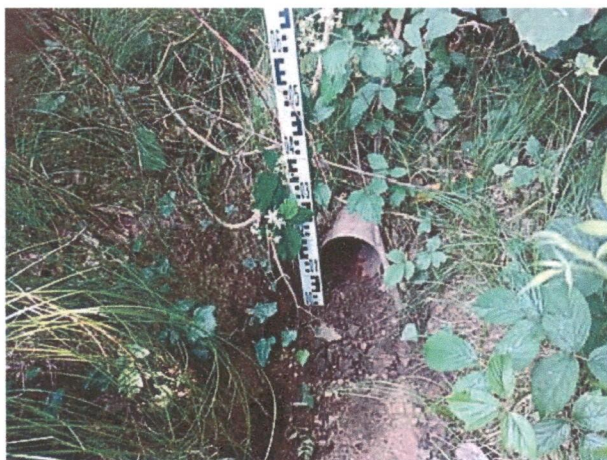
Foto 9: Auslauf DN 150 in die Geländemulde
