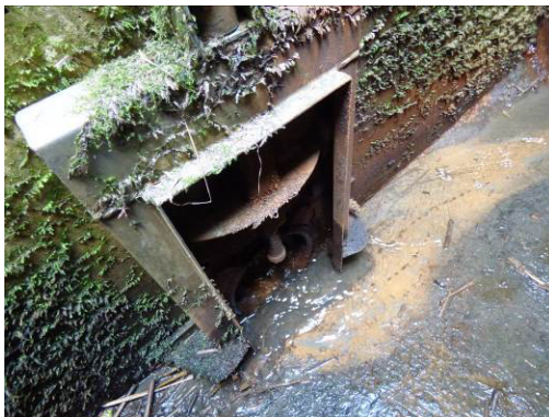
Grundablass mit Schieber
