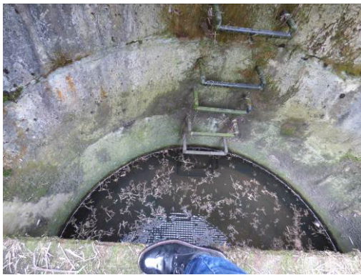
Einlaufbereich mit Dauerstau
