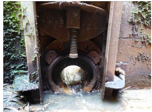
Grundablass mit Schieber
