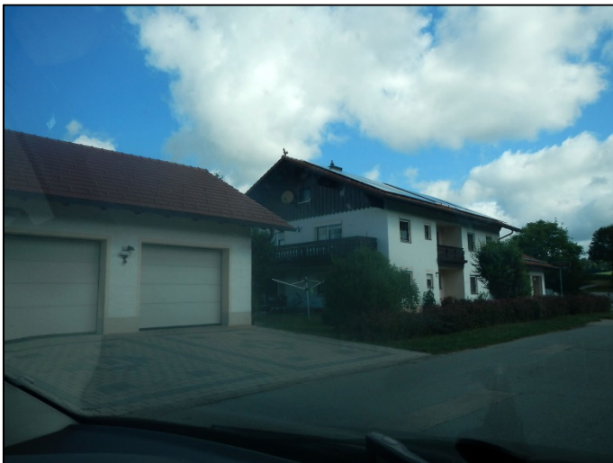
Abbildung 14: Wohnhaus "Grub 20" (hier: IO 7)
