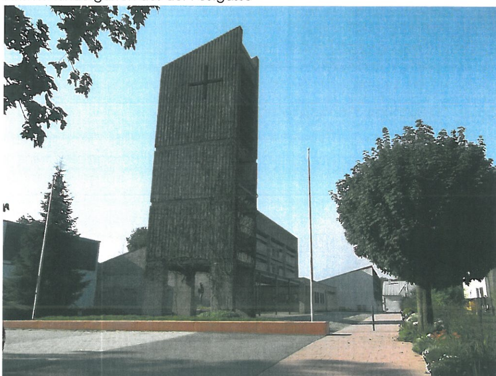
Ansicht Kirche aus der Wagnergasse
