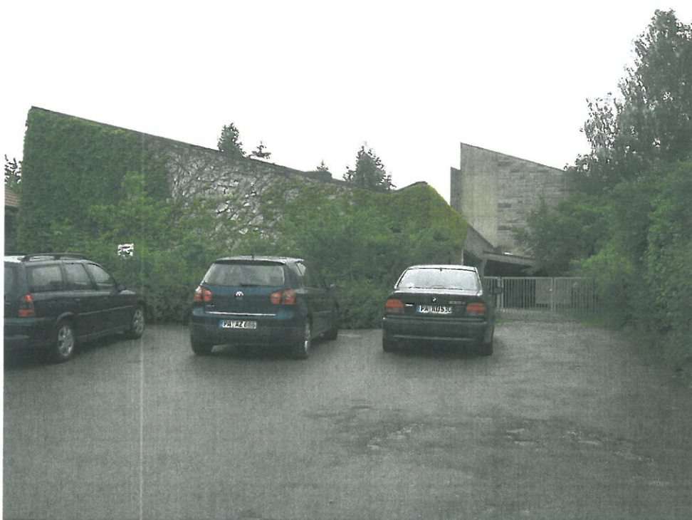
Ansicht Kindergarten aus der Postgasse
