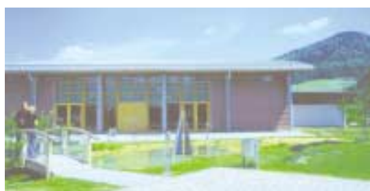
Adalbert-Stifter-Halle am Schulzentrum Hauzenberg 1997
