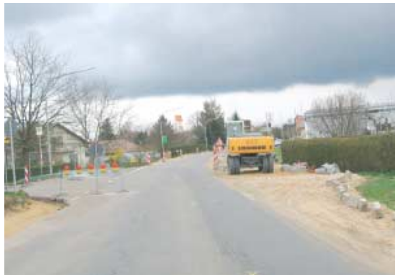
Gehwegbau in der Ortsdurchfahrt Jägerwirth 2008
