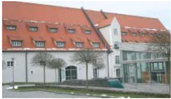
Historischer Salzstadel in Vilshofen nach Generalsanierung 2002
