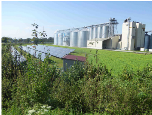
Blick von St 2110 nach Nord-Westen
