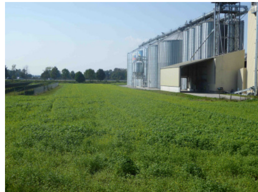
Blick von St 2110 nach Westen; Fläche Geltungsbereich
