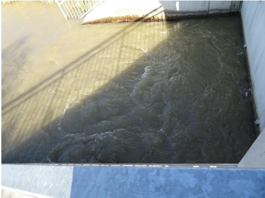
Abbildung B 5. Blick auf den Auslaufbereich des Zusatzdotationsbauwerkes (Verwirbelungen).
