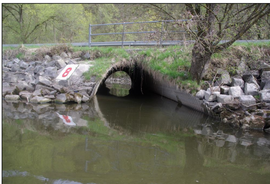
Abbildung 16: Anbindung Mannheimer Sporn mit der Donau über einen Rohrdurchlass
