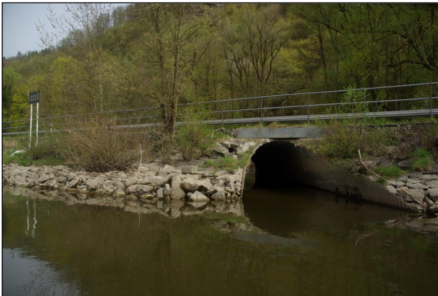
Abbildung 14: Anbindung Kernmühler Sporn mit der Donau über einen Rohrdurchlass
