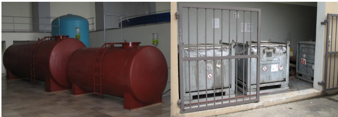
Abbildung 6: Lagerung von Betriebsölen und Sonderabfällen
