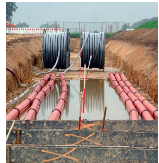
Abb. 18: Verlegung von 380 kV-Erdkabel auf einer Baustelle. Das Kabel wiegt ca. 40 kg pro Meter. Wegen der begrenzten Traglast der Lieferfahrzeuge sind die am Stück installierbaren Kabellängen auf ca. 500 bis 1.000 m begrenzt.
