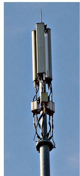
Abb. 59: Antennenkonstellation einer typischen Mobilfunkbasisstation mit drei Sektorantennen.
