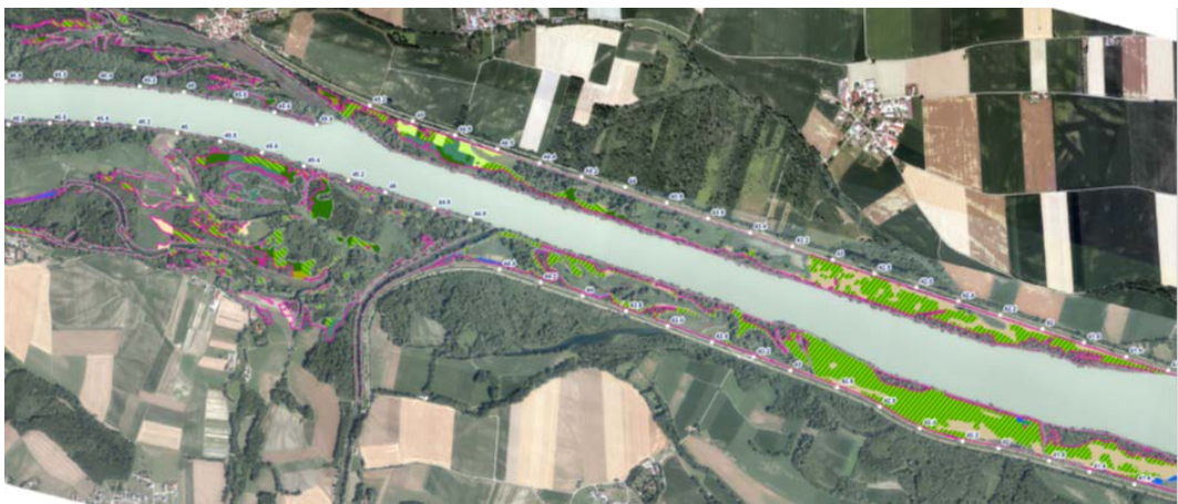
Abbildung 41: Situation im mittleren Bereich Stauraums bei MHQ – 2,0 m
