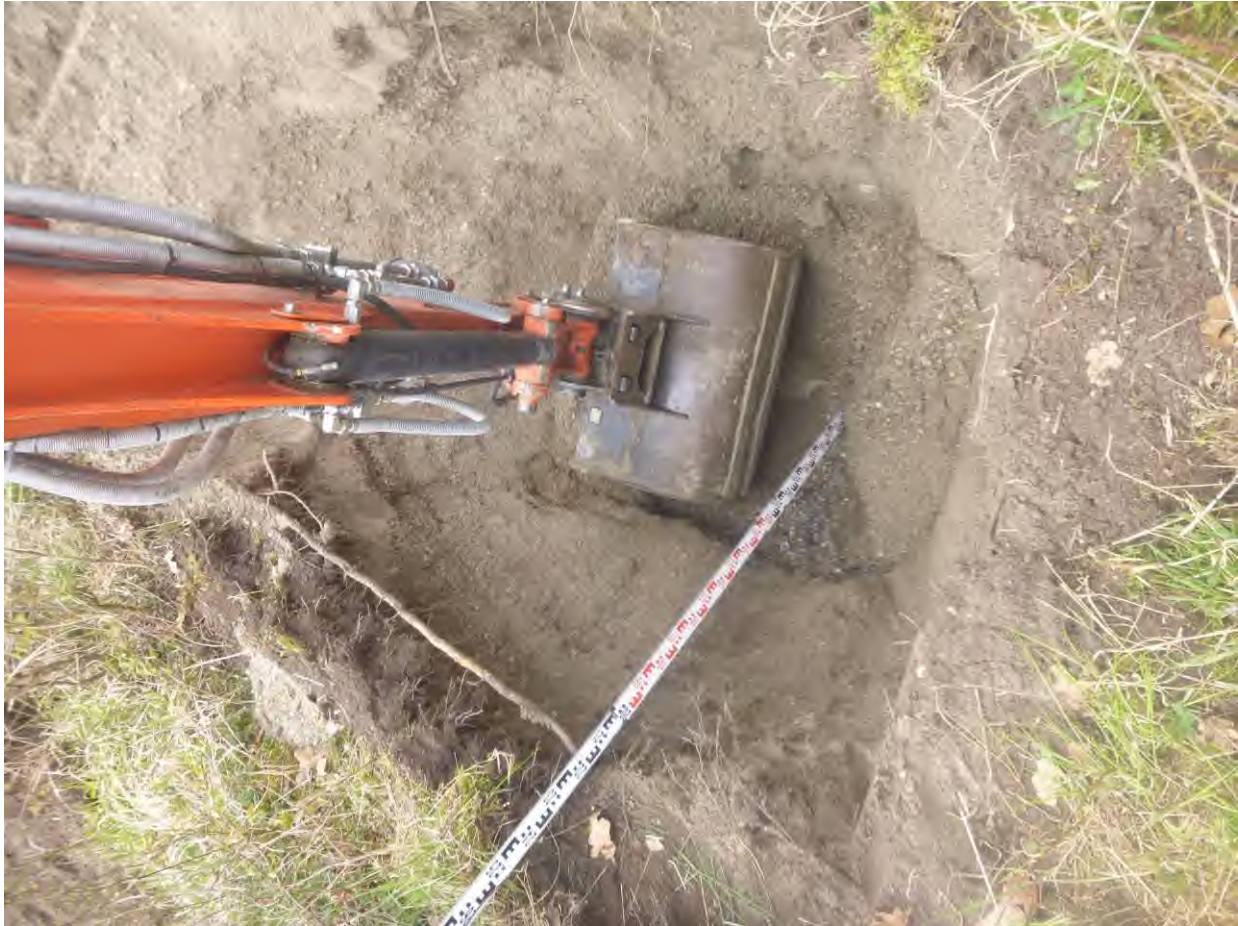
Abb. 8: Schürfgrube SCH7 (08.04.2019) in der Schurfsohle ist der Grundwasserzutritt erkennbar
