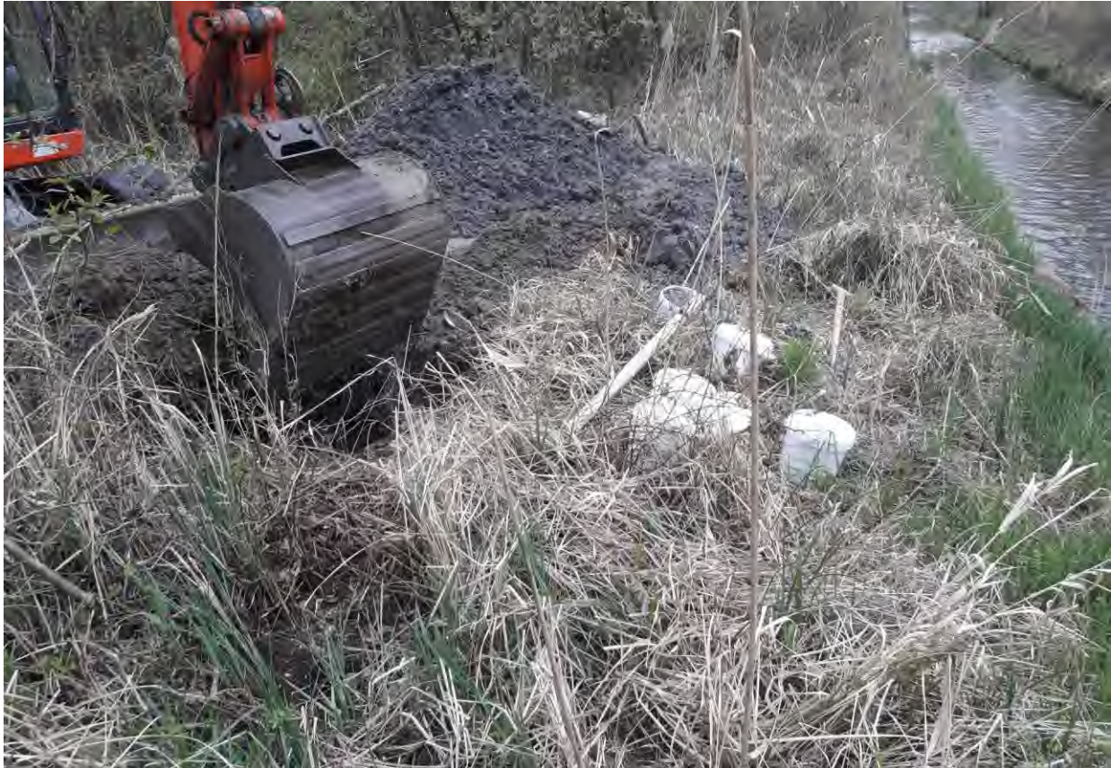
Abb. 3: Aushub Schürfgrube SCH3 (08.04.2019)
