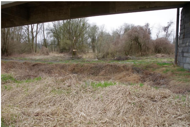
Abbildung 18: Relikt der Altwassersenke zwischen den Brückenpfeilern, Blick flussauf
