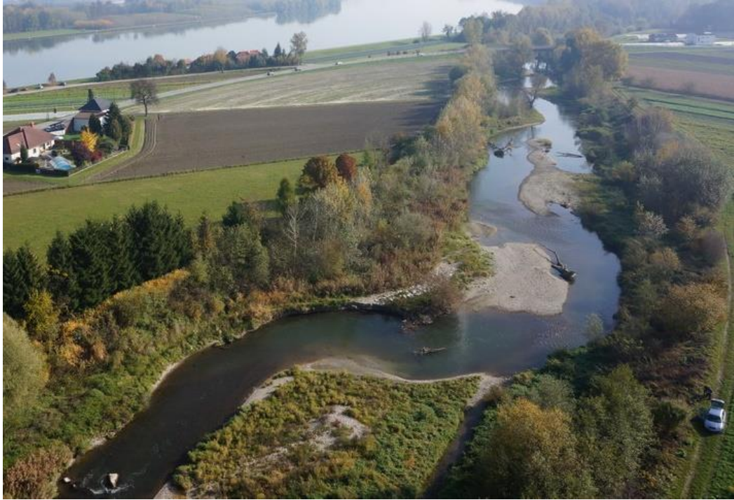
Abbildung 10: Umgehungsarm Donaukraftwerk Ottensheim-Wilhering (Gesamtlänge 14,2km)
