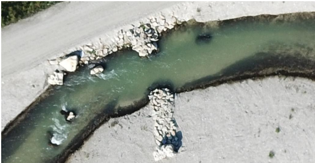
Abbildung 37: Wirkung von Buhnen und Störsteinen – Beispiel Umgehungsgewässer KW Ering-Frauenstein
