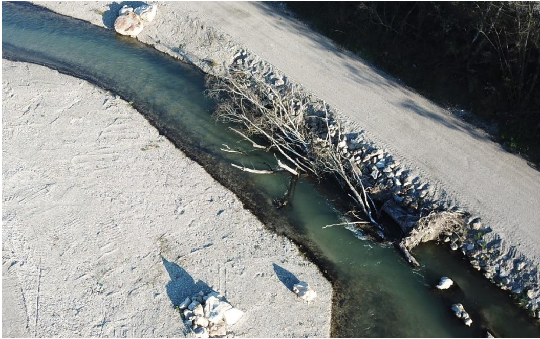
Abbildung 36: Wirkung von Totholzstrukturen – Beispiel Umgehungsgewässer KW Ering-Frauenstein
