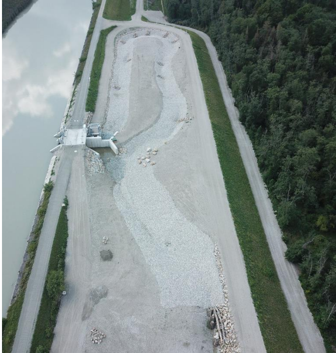
Abbildung 9: Abdeckung der Gewässersohle mit Grobkies (Einlaufgerinne und Beginn Rampengerinne - flussab Zusatzdotation) am Beispiel Umgebungsgewässer Innkraftwerk Ering-Frauenstein vor Dotationsbeginn
