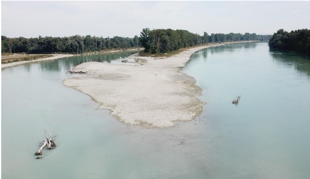
Abbildung 18: Inselkopf Unterwasserstrukturierung Innkraftwerk Ering-Frauenstein bei Niedrigwasser
